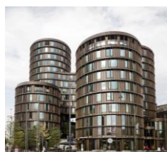
Axeltorv, Kontorbyggeri, Kbh.
